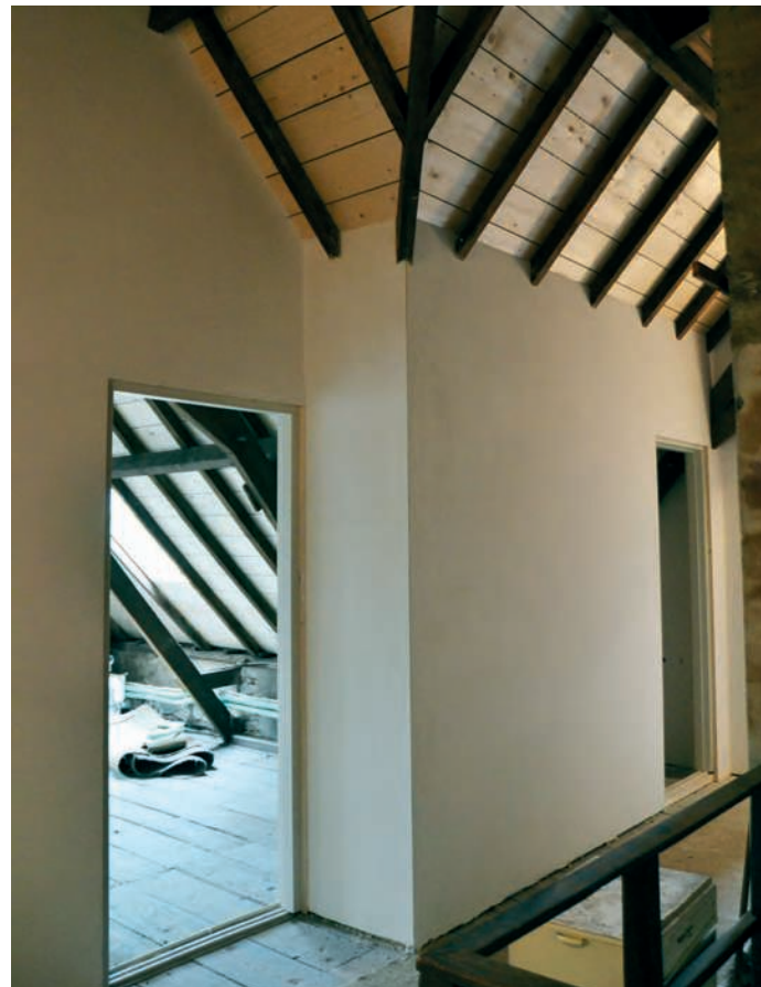
Tijdens de renovatie is tegen de bestaande steensmuur leem aangebracht om hem helemaal uit te vlakken.
